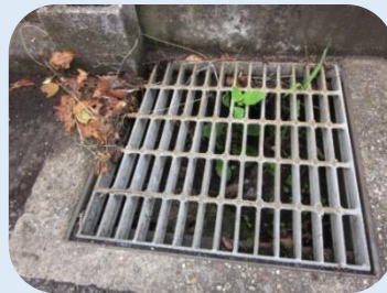
◎雨水桝内の泥や枯葉の除去
